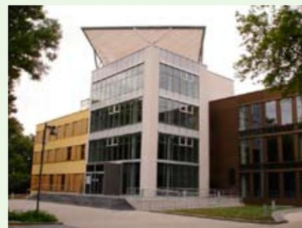
Das inHaus-2-Gebäude verfügt über einen Bürotrakt (links, gelber Bereich), einen Kernbereich (Mitte) und den Labortrakt (rechts, brauner Gebäudeteil, bestehend aus drei Etagen zu jeweils 750 qm Nutzfläche).
