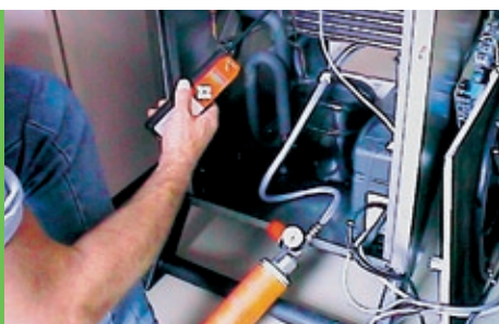
Dichtigkeitsprüfung eines Klimagerätes mittels Wasserstoffdetektion. Quelle: UST Umweltsensortechnik GmbH.
