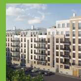
»inno« 63 Haus- und Gebäudetechnik
